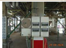
ตู้ Panel แบบป้องกันการเกิดประกายไฟ
